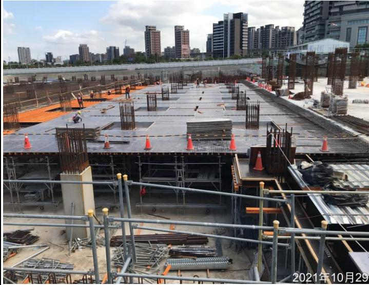
A view of the construction site for the 1F slab. It shows the steel reinforcement grid and formwork for the slab. The date '2021年10月29日' is at the bottom right. <p>拍攝日期：<br/>110年10月29日</p> <p>地點：<br/>A2 區</p> <p>說明：<br/>1F 板飛模作業<br/>模板組立</p> |
