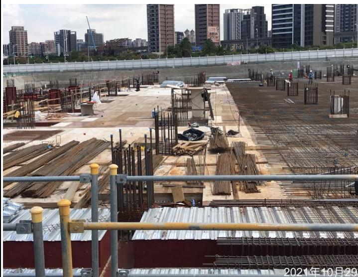
A view of the construction site for the 1F slab, showing the steel reinforcement grid and formwork. The date '2021年10月29日' is at the bottom right. <p>拍攝日期：<br/>110年10月29日</p> <p>地點：<br/>A4 區</p> <p>說明：<br/>水電放樣<br/>配管預備</p>                  |
